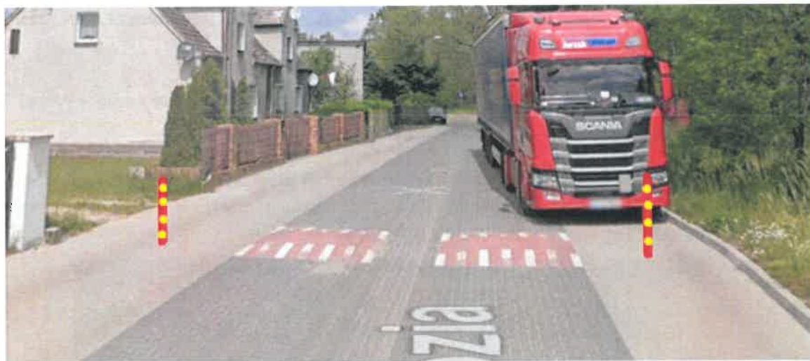
Rysunek 3 Przykładowe umiejscowienie słupków ograniczających przejazd samochodów
